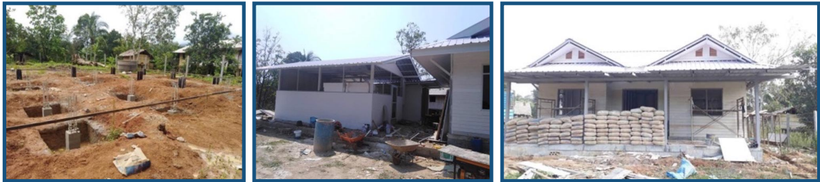
ระหว่างการก่อสร้างอาคารอเนกประสงค์ และอาคารสุขศาลาบ้านยูไนท์ คาดว่าจะเสร็จในปี 2562
