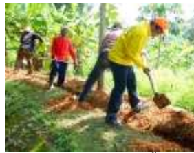
การขุดดินเพื่อวางท่อส่งน้ำ
