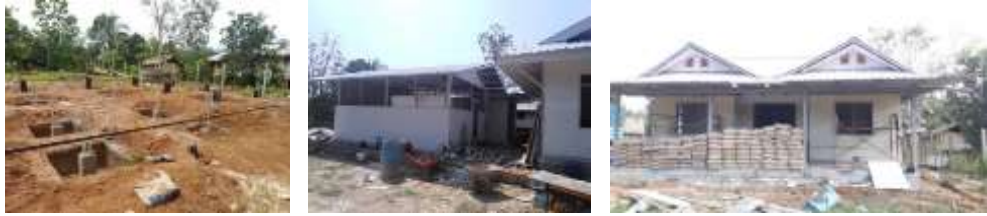
ระหว่างการก่อสร้างอาคารอนุบาลประสงฆ์ และอาคารสุขศาลาบ้านยูไนท์ คาดว่าจะเสร็จในปี 2562
